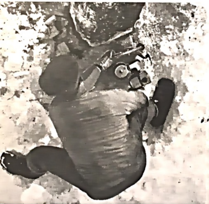
Vid matning på närmaste kant dras sågen inåt i skärriktningen med båda händerna. Armarna skall om möjligt hållas raka och dragningen skall uppstå genom mjuka böjningar i knälederna.
