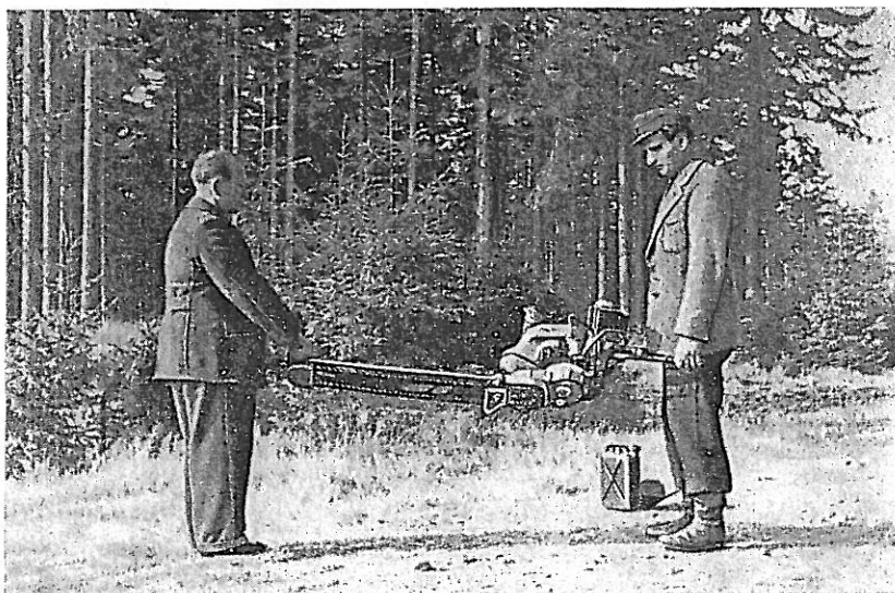
Abb. 15 Schwenken der Motorkettensäge von der Abläng- in Fällstellung
